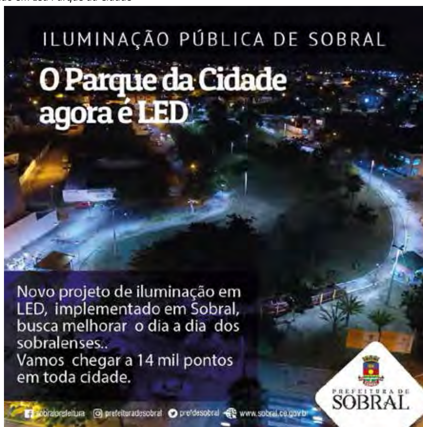
Figura 21: Iluminação em Led Parque da Cidade
